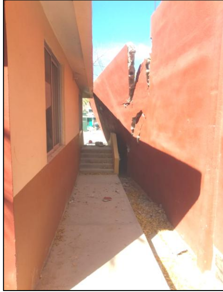
Remodelación UABCS Los Cabos, 2021.
