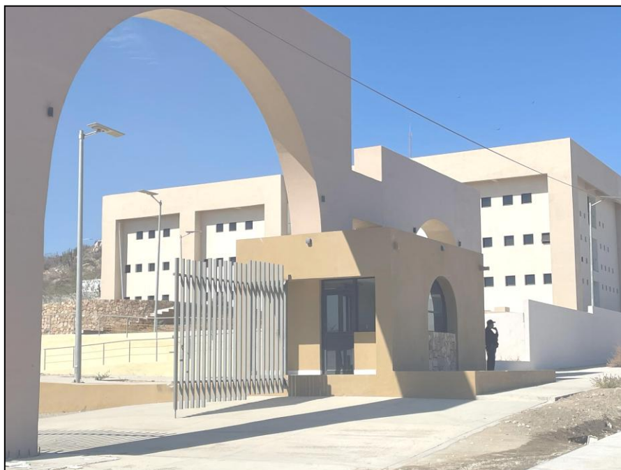
Sede Portales. Obra concluida.
