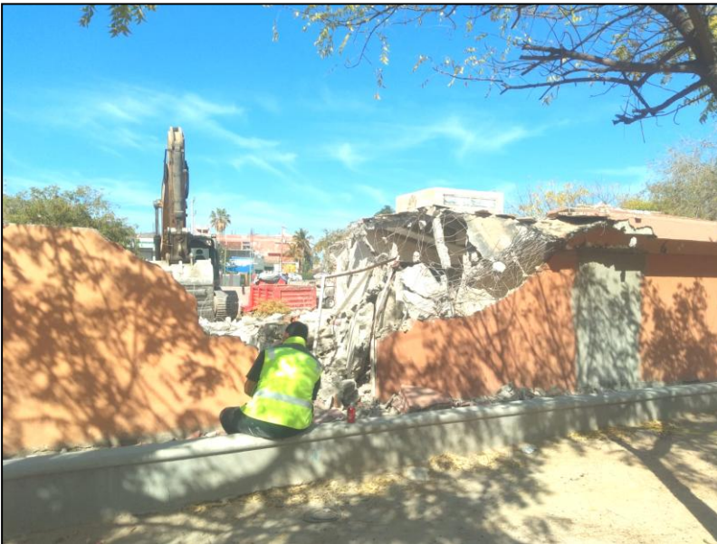
Remodelación UABCS Los Cabos, 2021.
